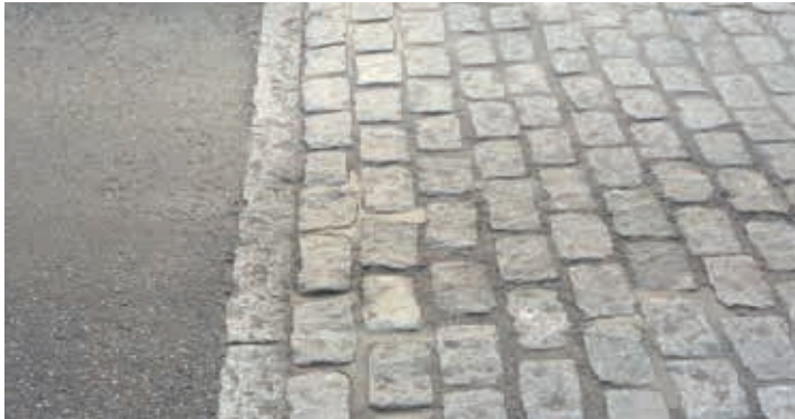
Exempel på byte av gatubeläggning som hastighetsbegränsande åtgärd.
